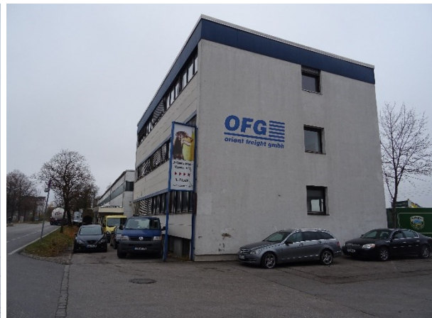
Bürogebäude, Ansicht von Osten ...
