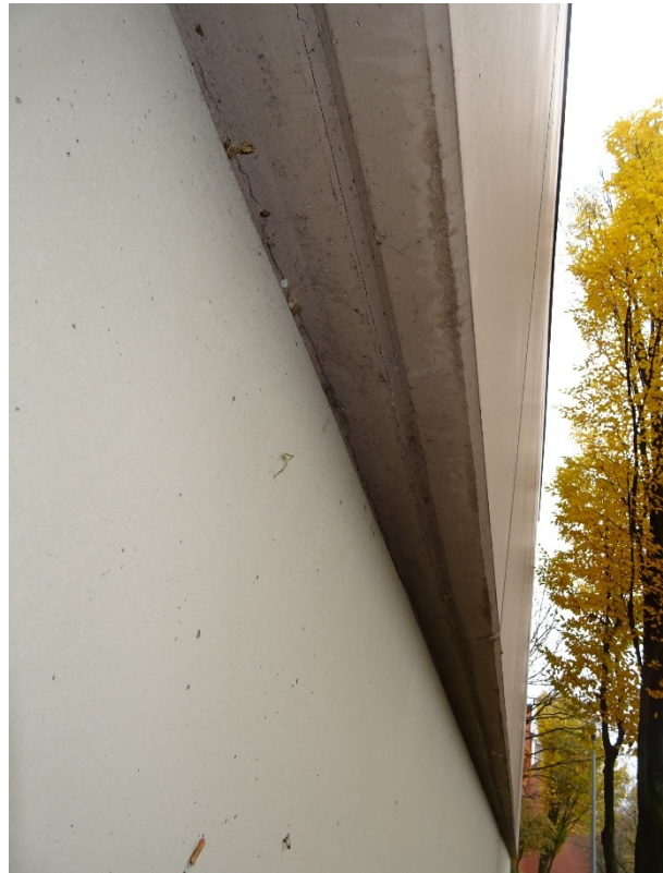
Ein weiterer Überstand an einem Gebäude, vollständig geschlossen.
