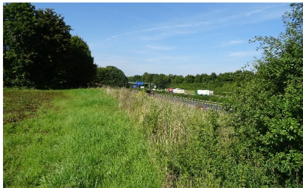
An der A. 99 auf Höhe der offenen Grasfläche, Blick nach Norden.
