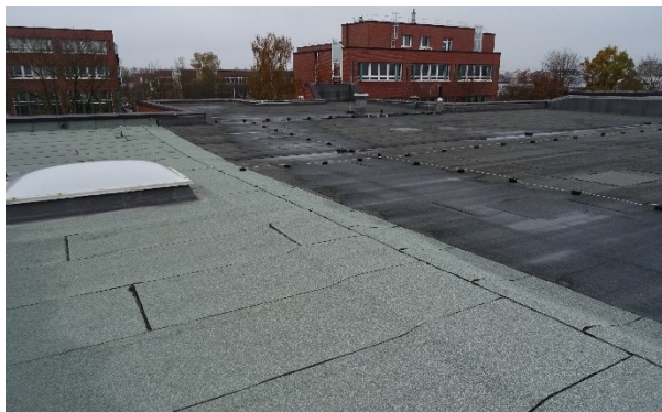
Eines der kontrollierten Flachdächer; keine Möglichkeiten für Vögel oder Fledermäuse.
