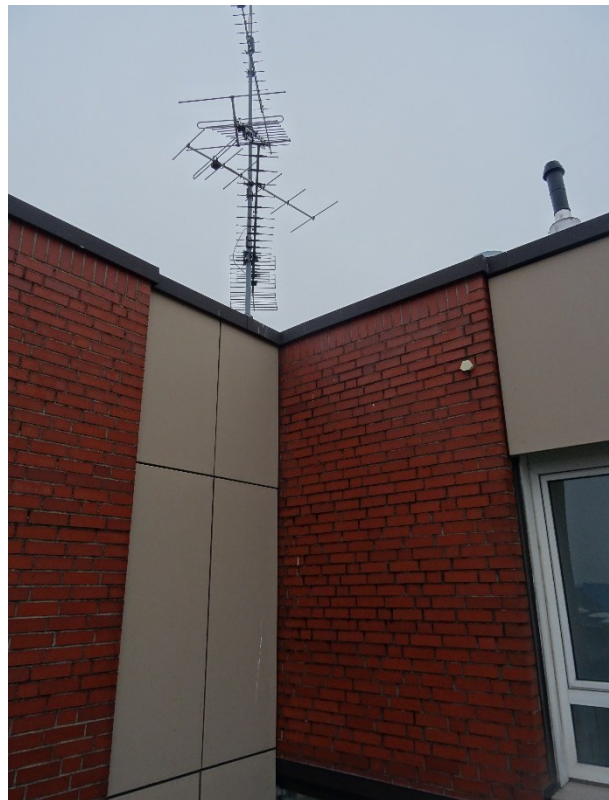
Alle Dachüberstände bzw. Attikableche ...
