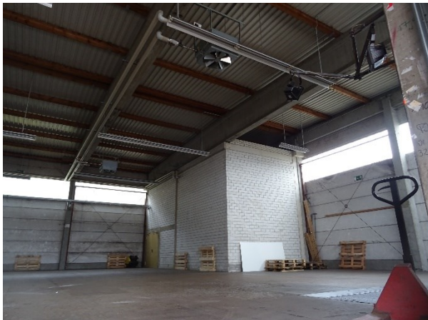
Lagerhalle, ebenfalls in Betrieb.
