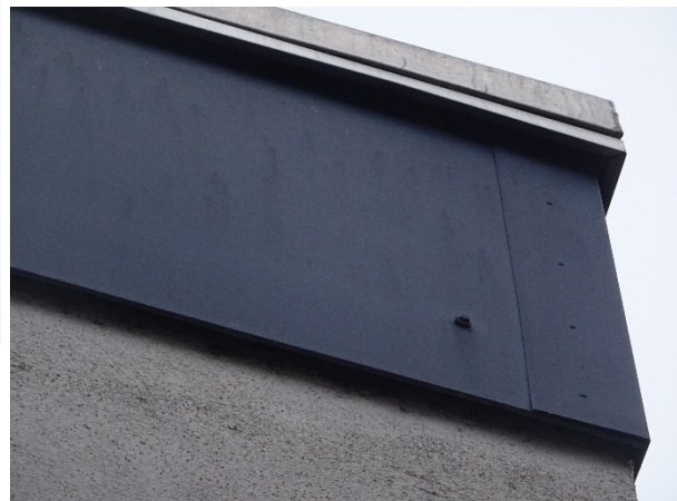
Die Spalten zwischen Verkleidung und Wand unterhalb der Dachkante müssen vor Abbruch ebenfalls auf Fledermäuse geprüft werden.
