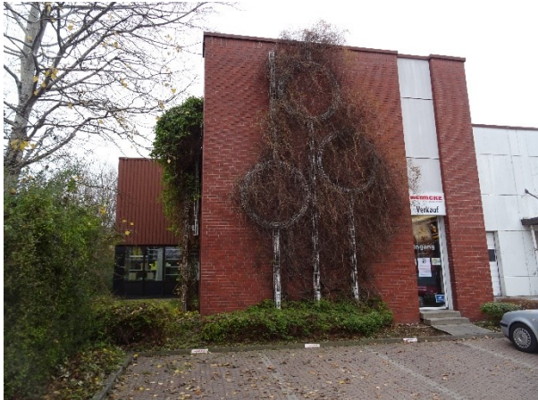
Nur an derart bewachsenen Fassaden können Nester frei brütender Vögel vorhanden sein; darauf ist dann zeitlich beim Abbruch zu achten.
