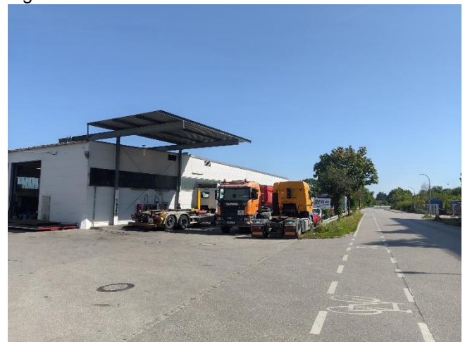
Reparaturgebäude an Feldkirchener Straße, Blick nach Osten
