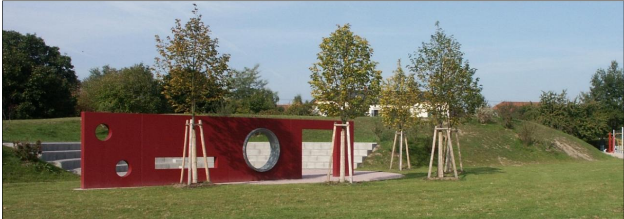
Abbildung 53: Kies-Wasser Erdbecken in Eggenstein Bildquelle: Universität Stuttgart, Institut für Gebäudeenergetik, Thermotechnik und Energiespeicherung.
