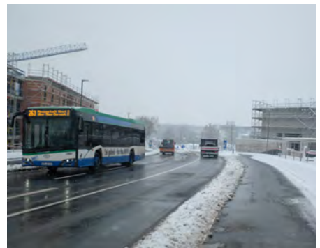
Sicherer Weg für alle: Die Verbindungsstraße zwischen Kirchheim und Heimstetten wird ergänzt durch sichere Wege für Fuß- und Radfahrer, sowie barrierefreie Haltestellen.
