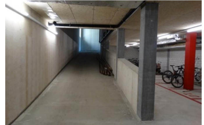
Beispiel Rampenneigung 6% Foto: giesserei Winthertur
