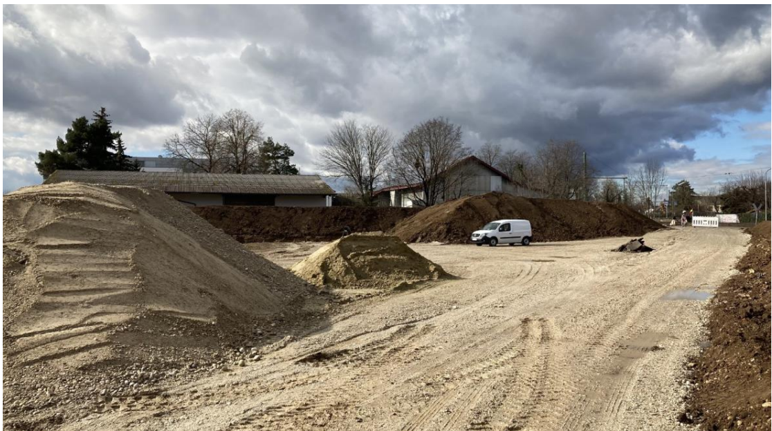
Abb. 10: Blick auf die Haufwerke (Blickrichtung von Südosten nach Nordwesten)
