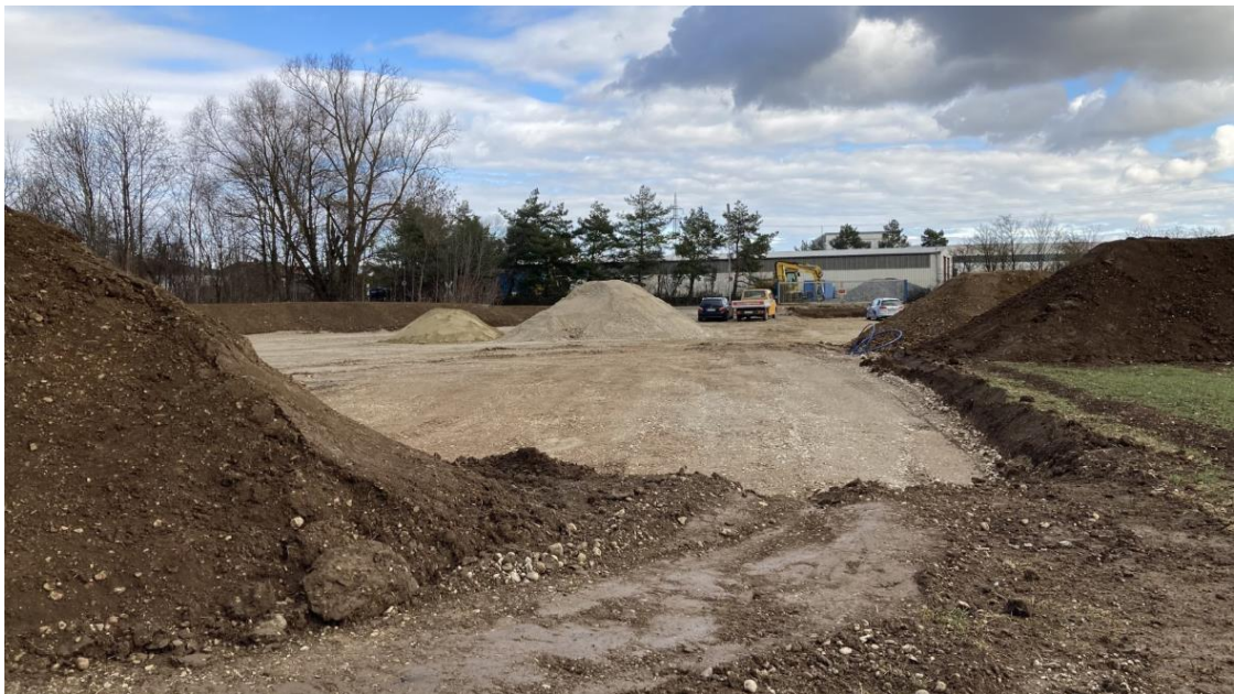
Abb. 5: Blick auf die Baustelleneinrichtungsfläche im Bereich des ehemals intensiv genutzten Grünlands mit Gehölzfläche und Taxetstraße im Hintergrund (Blickrichtung von Westen nach Osten)
