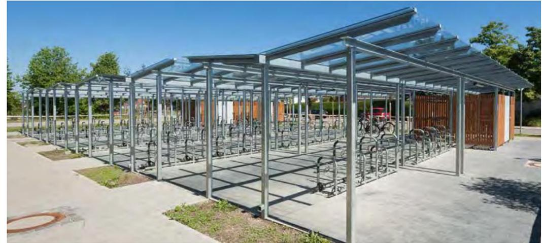
Beispielfoto Fahrradunterstand Stahlkonstruktion mit Glasdach
