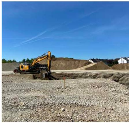
**Juli 2021:** In der Sphäre „Wiese“ im Süden des neuen Ortsparks laufen die Arbeiten im Sommer richtig an. Um das vorhandene Material optimal zu nutzen, wird Kies gefördert und für Arbeiten auf der Baustelle weiterverwendet.
