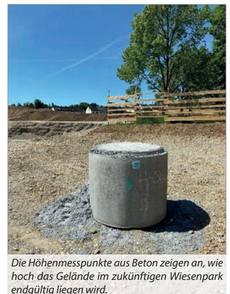
Die Höhenmesspunkte aus Beton zeigen an, wie hoch das Gelände im zukünftigen Wiesenpark endgültig liegen wird.
