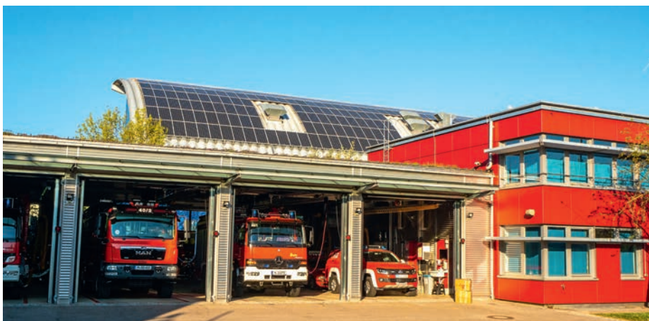
Standort der Feuerwehr in Heimstetten: Das Gerätehaus in der Hürderstraße wurde im Sommer 2000 an die Wehr übergeben und 2008 erweitert.
