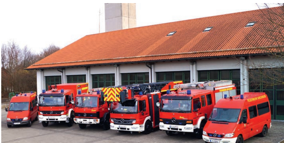
Standort der Feuerwehr in Kirchheim: In der Florianstraße befinden sich Fahrzeughalle, Funk-, Atemschutz-, Jugend-, Bereitschaftsraum, eine Schlauchwaschanlage sowie ein Lehrsaal.
