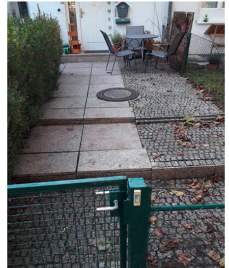
Bild 3: Negatives Beispiel mit vielen Verbauungen und geringer Wasserdurchlässigkeit.
