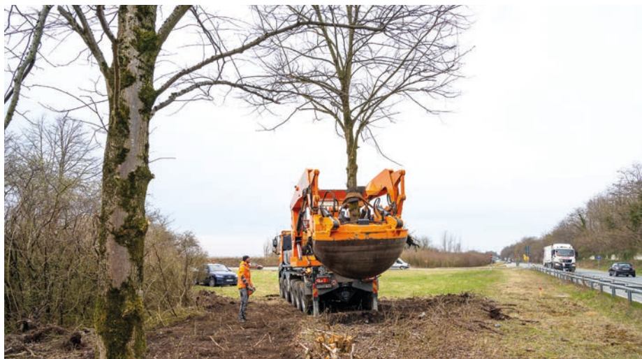
Im Zuge der Vorarbeiten zu Kirchheim 2030 wurden an der Staatsstraße zwei Linden verpflanzt. Die Großbäume stehen nun in der Nähe des Gymnasiums. Sie haben ihren neuen Platz am südlichen Teil des Wäldchens im künftigen Ortspark gefunden.
