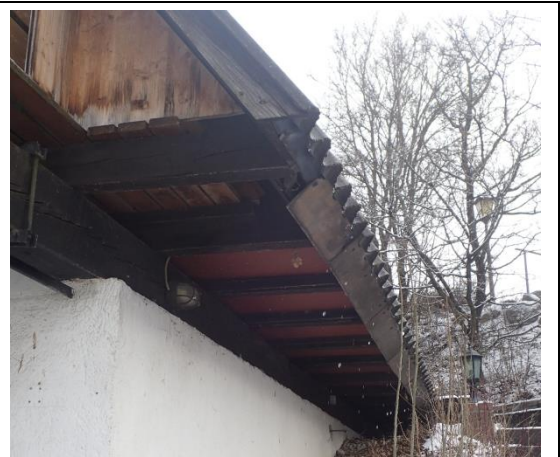
Spalten in Dachüberstand und Dachabdeckung als potenzielle Quartiere von einzelnen Fledermäusen im Stationshaus der Wasserwacht
