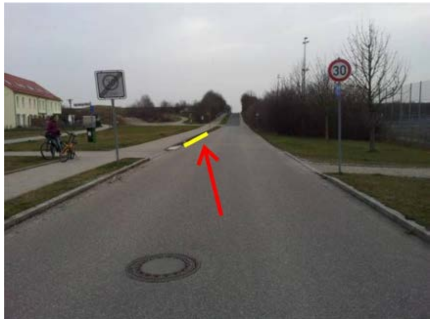
Bajuwarenstraße Schaffung einer Überlei- tung für den Radverkehr durch Aufbringen einer Asphaltdecke
