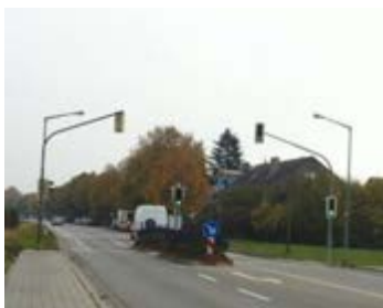
Fußgängersignalanlage Münchner Straße
