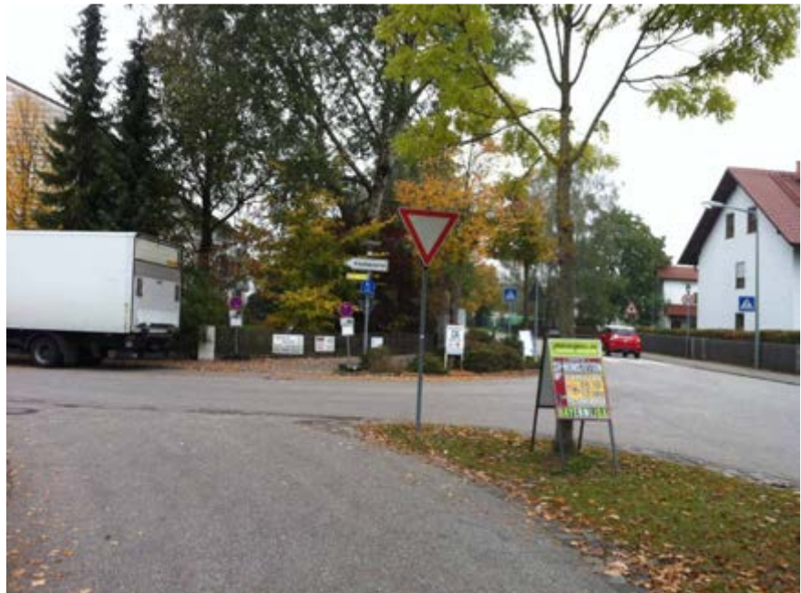
Erdinger Straße zwischen Flurstraße und Anschluss Staatsstraße 2082 Aufhebung der Radwegbe- nutzungspflicht
